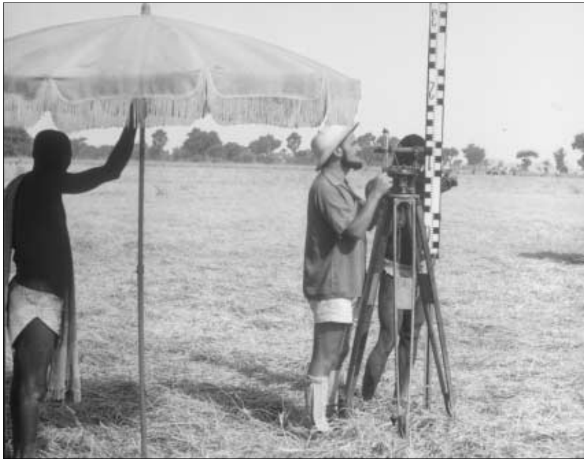
Stanislas Mroczek réalise un levé au tachéomètre, dans les années 1950. La Mission Tchad avait fait appel aux équipes de l'ATGT pour l'aménagement de ce territoire.
